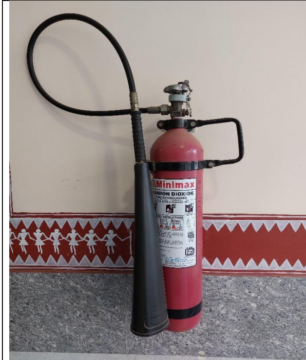
Co2 type fire extinguisher
